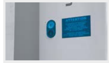
Bedienungsschalter Öffnungs- und Schließvorgang
